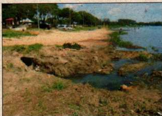
Degradação - Poluição atingindo o reservatório, Americana (SP)
